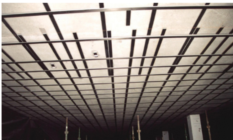
Fot. 1 Bierne wzmocnienie płyty żelbetowej taśmami CFRP [1]
